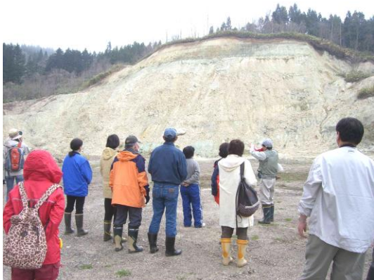
桜野地区の八雲層の地滑り跡地 （凝灰岩）
